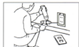
●配線ケーブルボックスのほめ込み・すき間充てん・固定。
