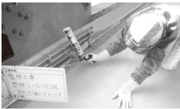
●モルタル系グラウト注入時の型枠のシーリングに。
